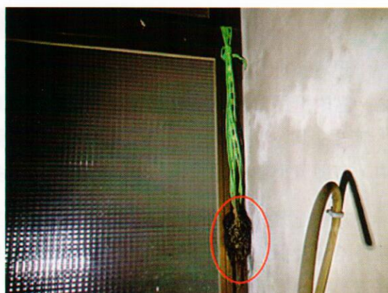
圖5.窗框吊掛打結曬衣繩周邊照
