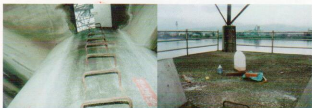
照片2-5：爬上電塔後發現汽油桶、燒熔物數處與打火機等物品
