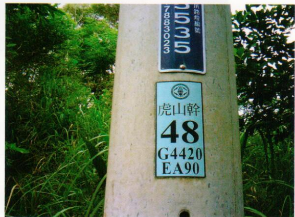
照片七 電線桿上9碼的電力座標
