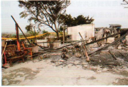
燒毀的工寮現場
