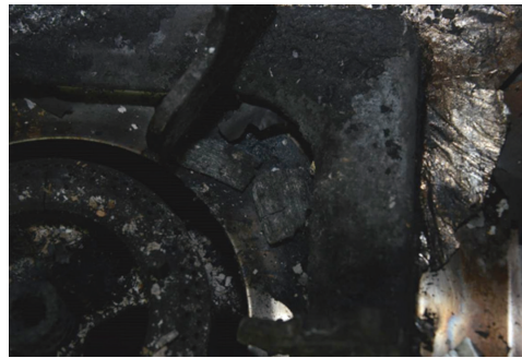
圖12、案例1瓦斯爐周圍發現木炭殘跡
