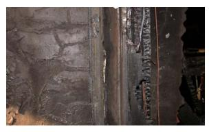
場勘察必須利用一些比較可靠的燃燒痕跡進行分析鑑識,所有關於燃 燒痕跡鑑識的基礎必須能解讀火場中各種火災語言(fire language),如 煙燻痕跡 (smoke staining)、木材碳化深度(depth of char)、燃燒最低 點(low point of burning)、熱分佈特徵(heat indicators)、混凝土破裂型 態(spalling)、金屬與油漆等之變色(discoloration)特徵、玻璃裂痕(glass fracture) 與縱火相關燃燒型態(burn patterns)等特徵,以進行研判火勢 蔓延的方向。整個勘察順序是先確定起火處所,再研判起火點,最後 決定起火原因。
